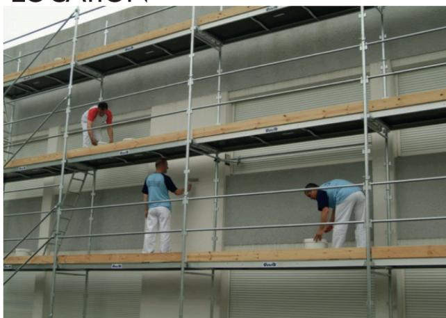
L'ÉCHAFAUDAGE FIXE RÉPOND À DES TRAVAUX DE MAÇONNERIE COURANTS
