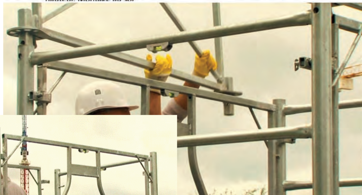
Ecrous des vérins positionnés à la même hauteur. Montage au sol
